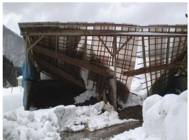
写真 38 堆肥舎屋根の損壊状況
