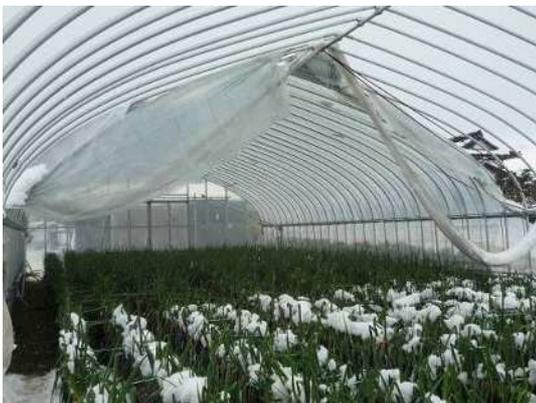
写真 47 被覆資材が破損し、作物が雪を被った状況
