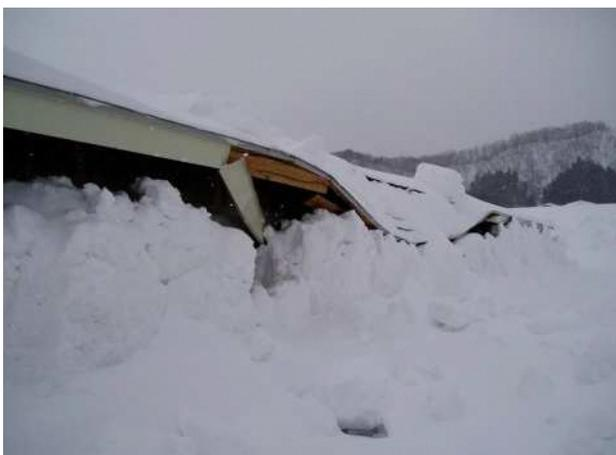
写真 37 畜舎軒先の損壊状況
