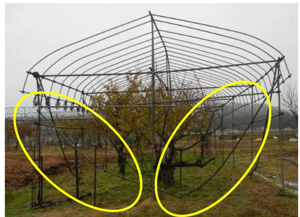
写真 30 沈降力により変形した筋交いパイプ
