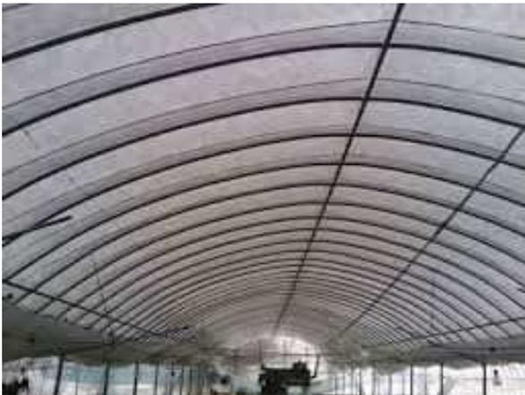
写真 32 屋根面に着雪し、融雪が必要となっているハウスの状況
