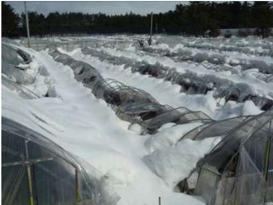
写真45 倒壊したハウスの状況
