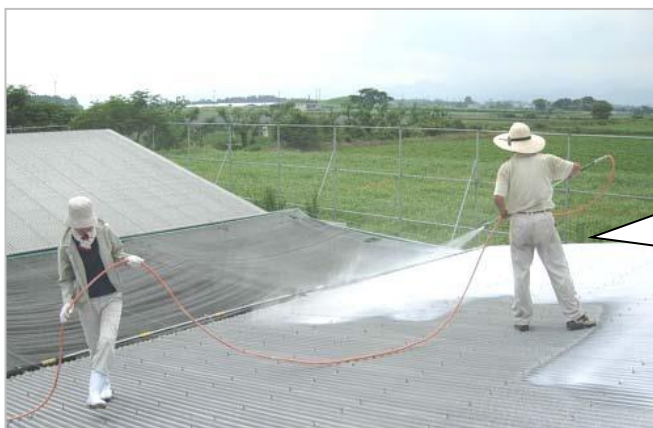
屋根への石灰の吹き付け（宮崎県）
