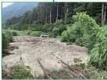
土砂流入 (越後片貝～越後金丸間)
