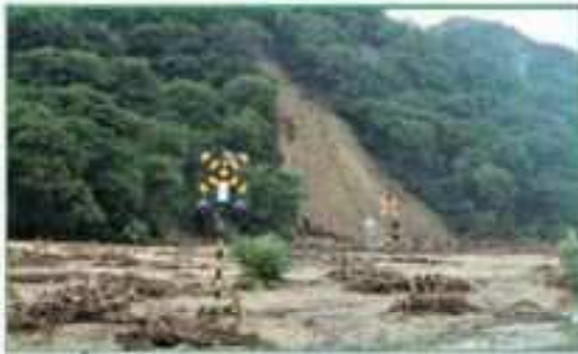
大規模土砂流入 (坂町～越後大島間)
