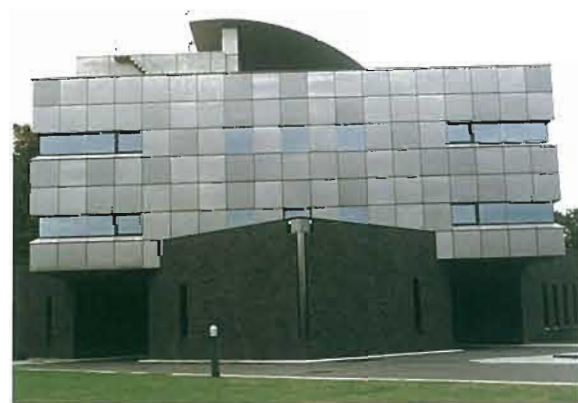
屋外タンクを上屋で覆い、建物と一体的にデザインした例
