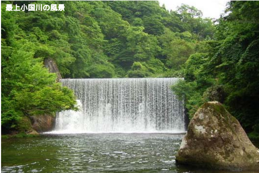
最上小国川ダム建設予定地の100m上流にある砂防ダム(高さ10m;昭和39年完成)
