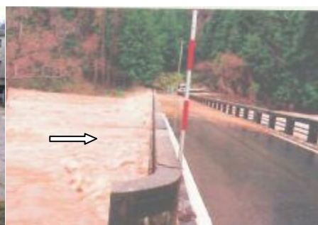
県道最上西公園線:白山橋
