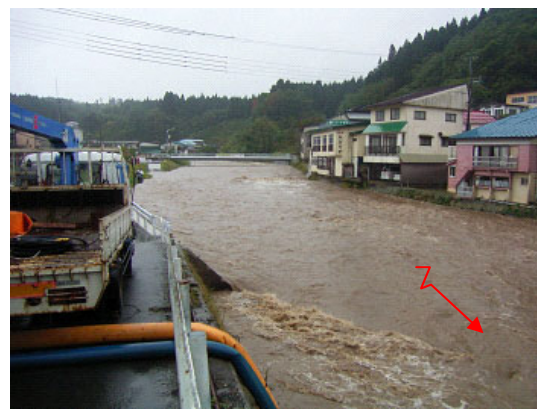
平成 21 年 10 月 8 日（台風 18 号） 床下浸水 3 戸
