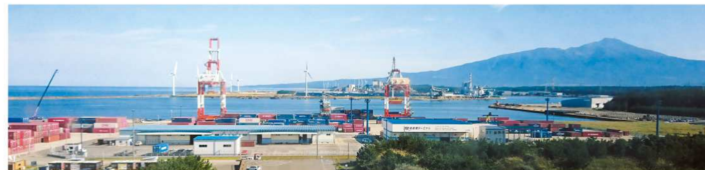
酒田国際ターミナル全景 左から高砂西上屋、コンテナ・フレート・ステーション(CFS)上屋、コンテナヤード
