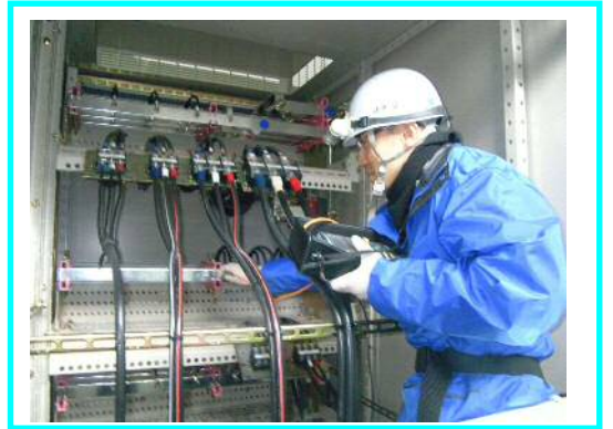
電気設備の点検
