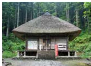
8番札所 深山観音(白鷹町) 県内最古の建造物で国指定重要文化財。
