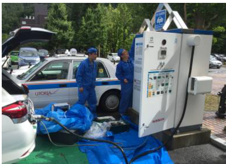
←県庁前の急速充電器のケーブル交換工事
