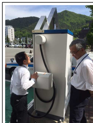
日常点検の様子 (週2回点検)
