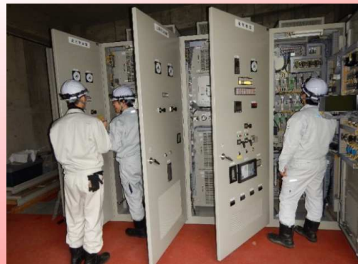
電気設備点検作業(浄水場・電気室)
