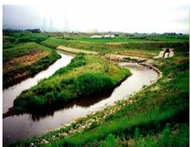
河川改修後 1年経過
