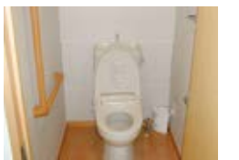
和式から洋式トイレへ 手すりの設置
