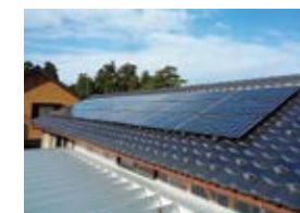
太陽光発電設備の設置
