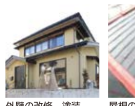
外壁の改修、塗装
