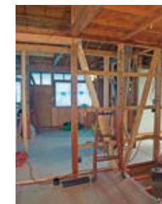
筋交いなどを設置
