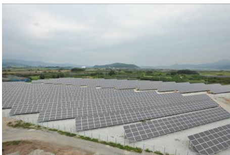
村山浄化センター
