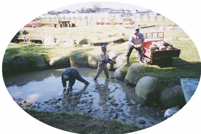
住民参加の直営施工（庄内町）
