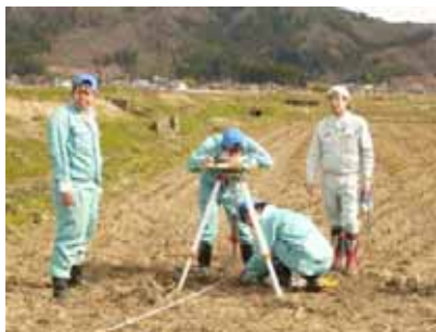
県立置賜農業高校環境緑地科環境プロジェクト班協力による水田魚道設置箇所の現地測量（H22.4.26）
