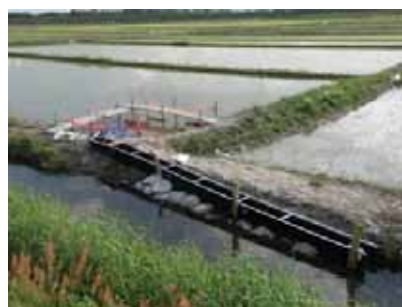
水田魚道設置状況 4度タイプ（H21.5.21）
