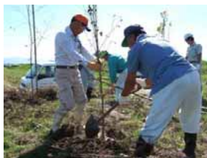
保全池の親水空間施設を直営施工により行った。(H17.8)
