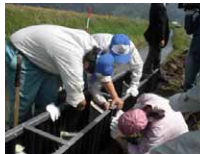
地域住民、高校生協働により水田魚道2タイプを直営施工により設置（H22.5.21）
