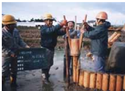
保全池の親水空間施設を直営施工により行った。(H15.12.15)
