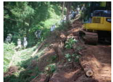
法面に現地発生丸太や伐根を利用
