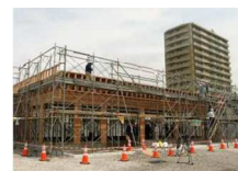
木造コンビニ (建設中: 秋田県)
