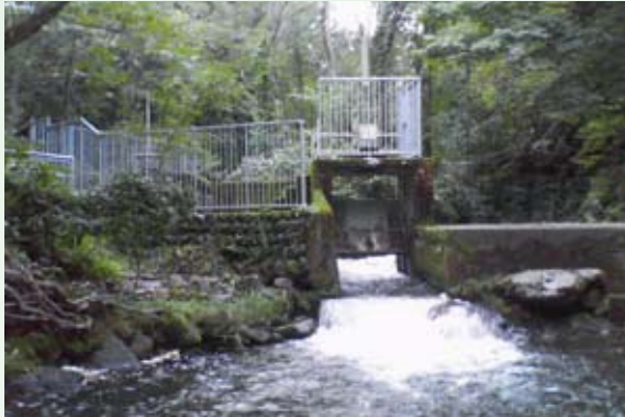
写真1 河川横断施設（取水堰）
