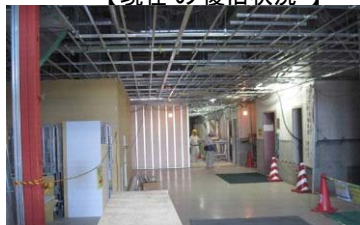
壁・天井を復旧中
