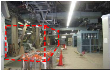
配電盤を撤去し、基礎架台設定中
