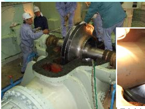
ポンプ本体の分解・調査状況
