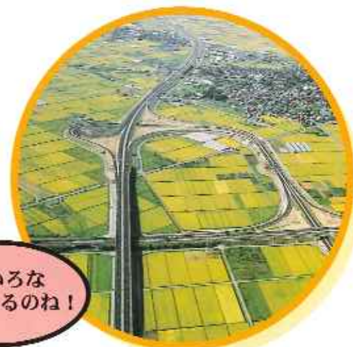
高速道路 「東北中央自動車道」「山形自動車道」
