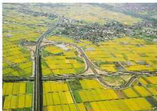
△東北中央自動車道(山形ジャンクション)
