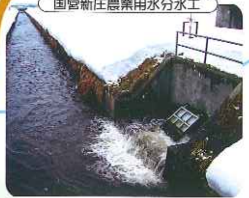
国営新庄農業用水分水工
