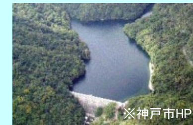
布引ダム(神戸市) 明治33年竣工(114年) ※神戸市HP
