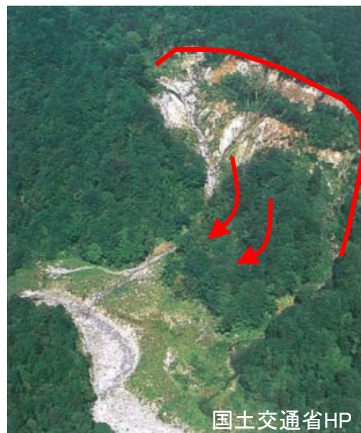
大越川の崩壊状況
