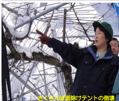
さくらんぼ雨除けテントの倒壊
