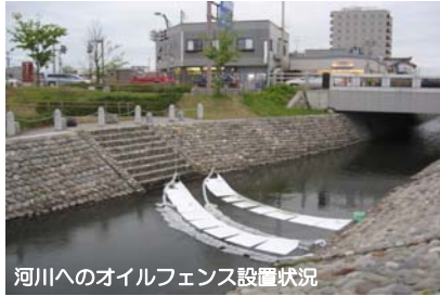
河川へのオイルフェンス設置状況
