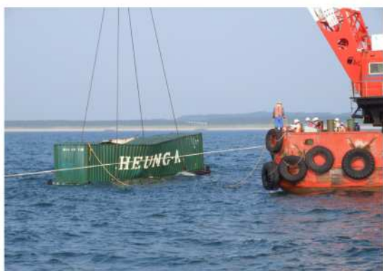
沈下コンテナの引揚げ (H18.8)
