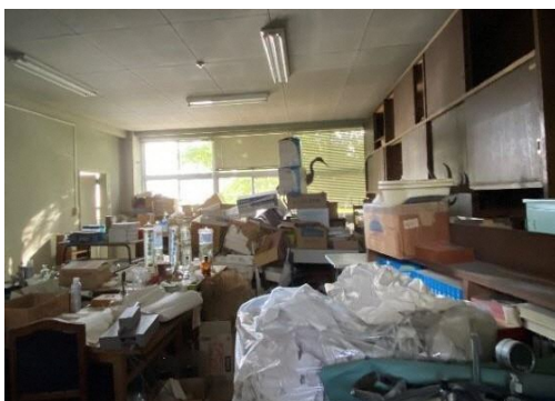
(旧理科棟 内部)
