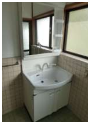
⑧1階洗面台
