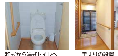
和式から洋式トイレへ 手すりの設置
