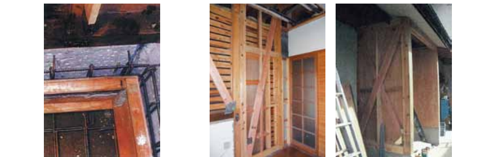
基礎を補強する工事 筋かいや構造用合板で補強する工事
