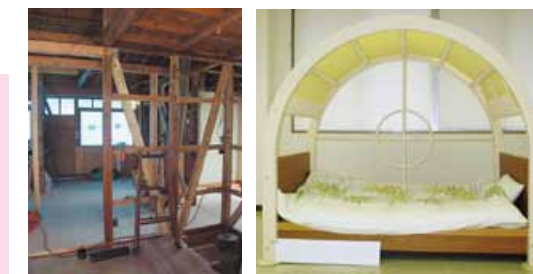
筋かいなどを設置 防災ベッドの設置
