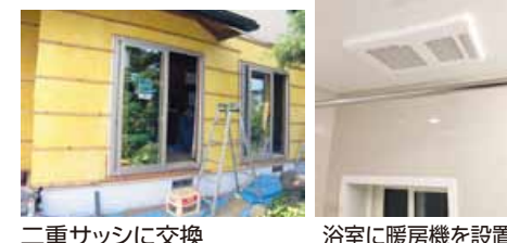
二重サッシに交換 浴室に暖房機を設置
