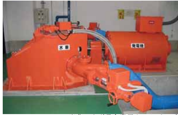
図 4-2 笹野浄水場に設置されている発電機
