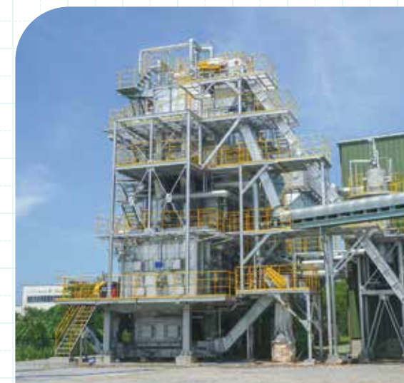
バイオマス発電所
