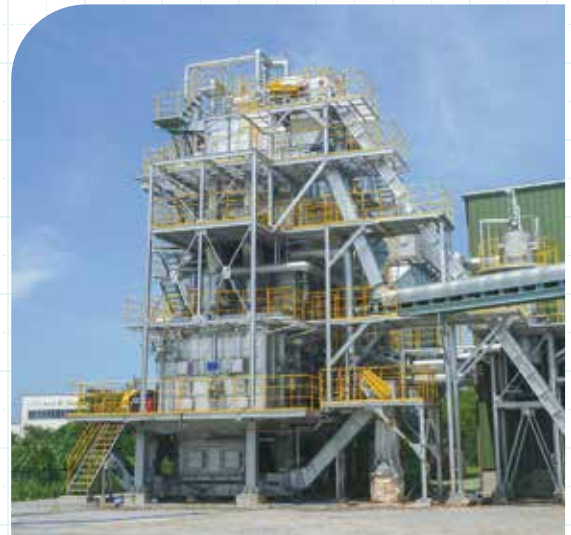
バイオマス発電所
