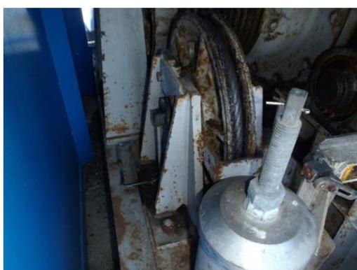
開閉装置(ロープ端末装置)の劣化により機能不全のおそれ
