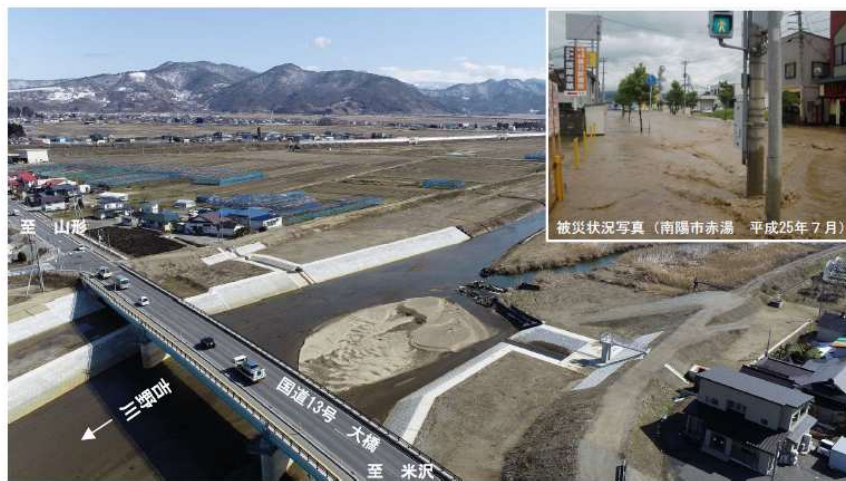
▲吉野川整備状況（南陽市大橋付近） 令和6年3月撮影
