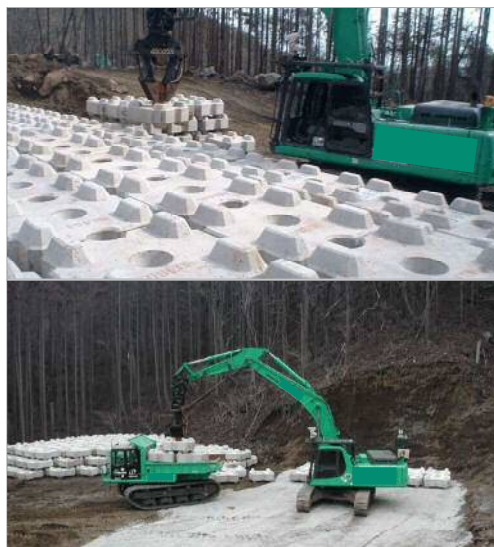
無人化施工の事例（三宅島）
