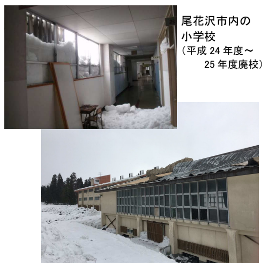
廃校舎の現状
