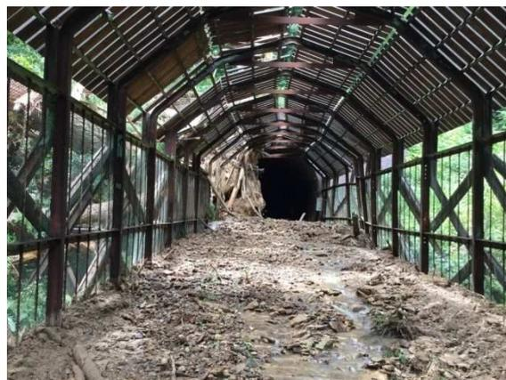
H30.8月 陸羽西線における大雨による線路への土砂流入の状況
