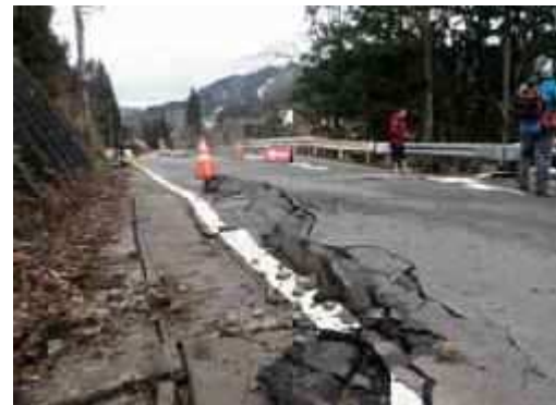
平成26年3月に発生した国道287号の地すべり
