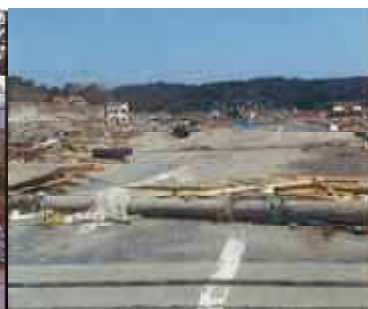
大地震(津波)による道路の被災
