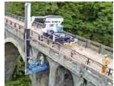
橋梁の計画的な点検（橋梁点検車）
