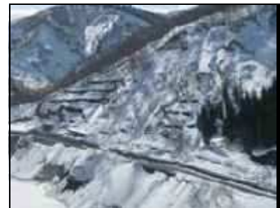
(主)米沢飯豊線(飯豊町高峰) 雪崩により平成27年3月4日～13日 10日間にわたり全面通行止め
