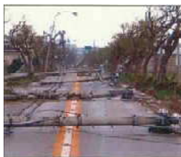
台風による道路の被災
