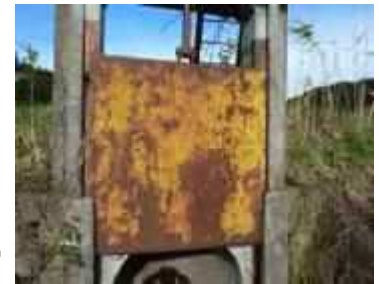
長寿命化が進まない河川施設 (樋門の門扉)
