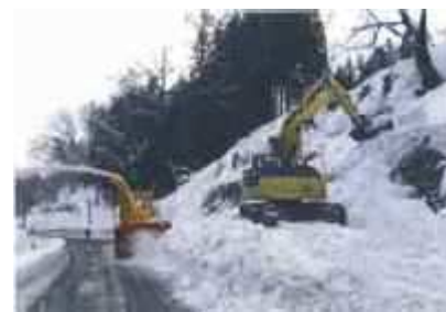
国道344号(真室川町宮沢) 雪庇処理作業
