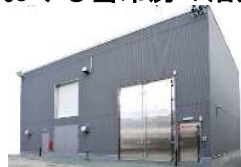
雪冷房施設の外觀
