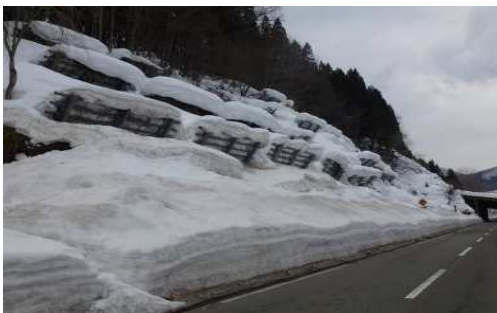
雪崩防止施設
