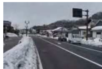
堆雪幅が確保された道路
