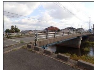
▲苗津新橋 全景
