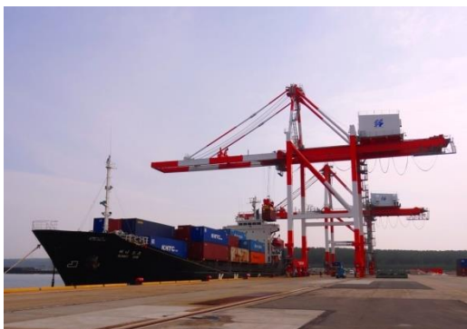
コンテナクレーン(2基)とコンテナ貨物船
