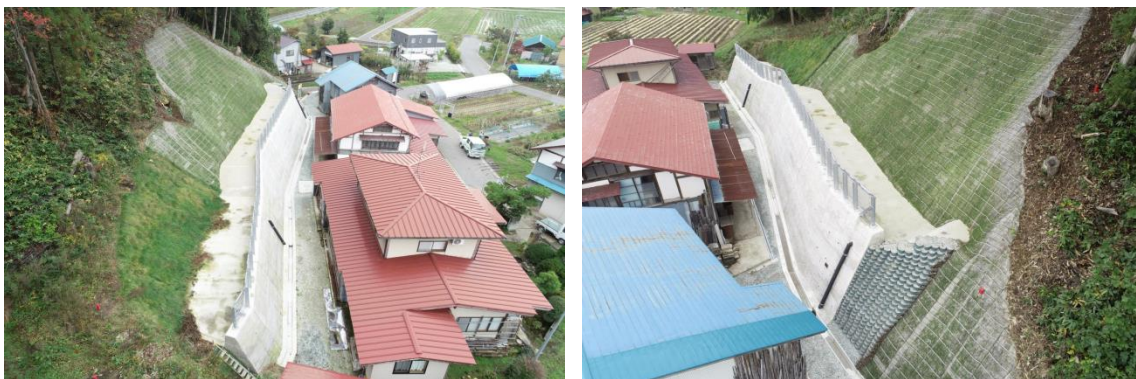
大淀 急傾斜地崩壊対策事業（村山市：完了後 撮影）
