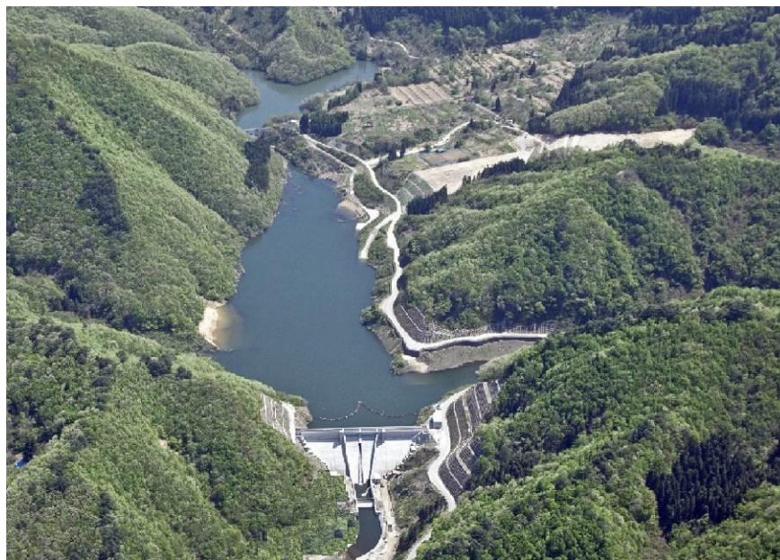
留山川ダム（平成23年7月竣工）
