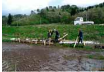
水路の土手整備
