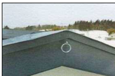
【克雪化リフォームの例】 雪下ろし用命綱を固定する 金具の取付け
