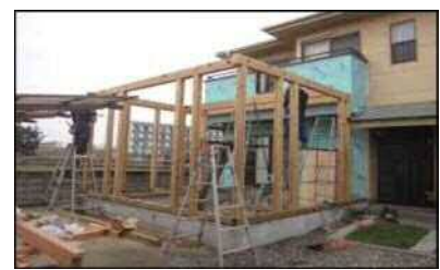
【三世代世帯でのリフォームの例】 居室の増築工事
