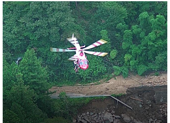
令和元年台風第19号 (宮城県丸森町地内)
