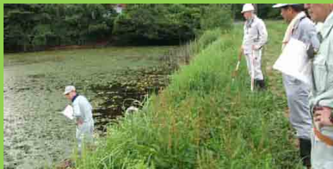
ため池堤体の“はらみ”を目視点検
