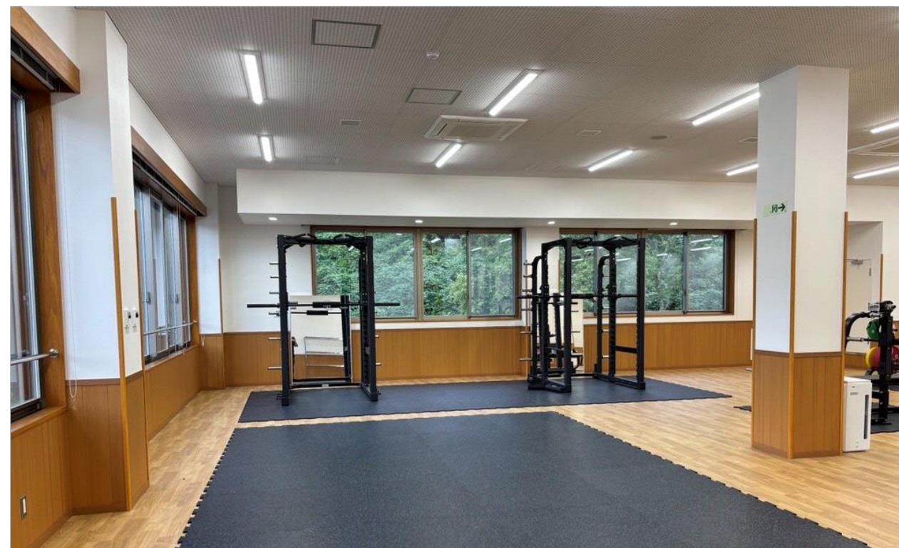
腰壁（トレーニングルーム） 木材使用面積：56.8m 2
